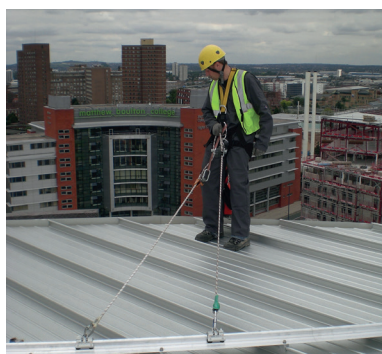
Onderhoud op daken
