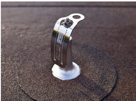
Daken met roofing
