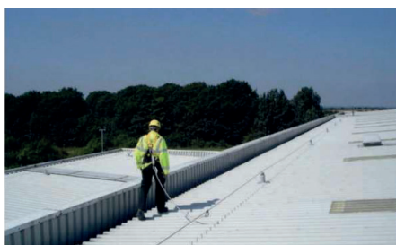
Onderhoud op daken
