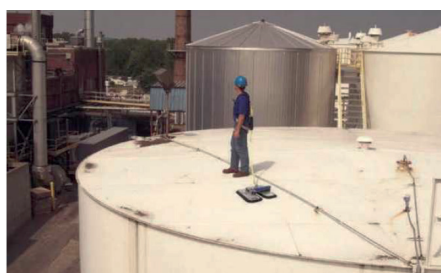
Onderhoud industriële installaties
