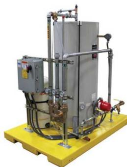
Exemple de système de ballon d'eau chaude pour alimenter un réseau en eau chaude.
