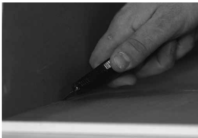
Gipsplaten kunnen stofvrij op maat worden gemaakt
