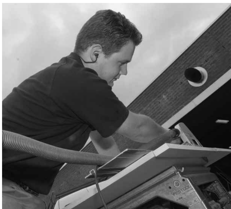
Afzuigslang over een geleider voorkomt dat het werkstuk beschadigt
