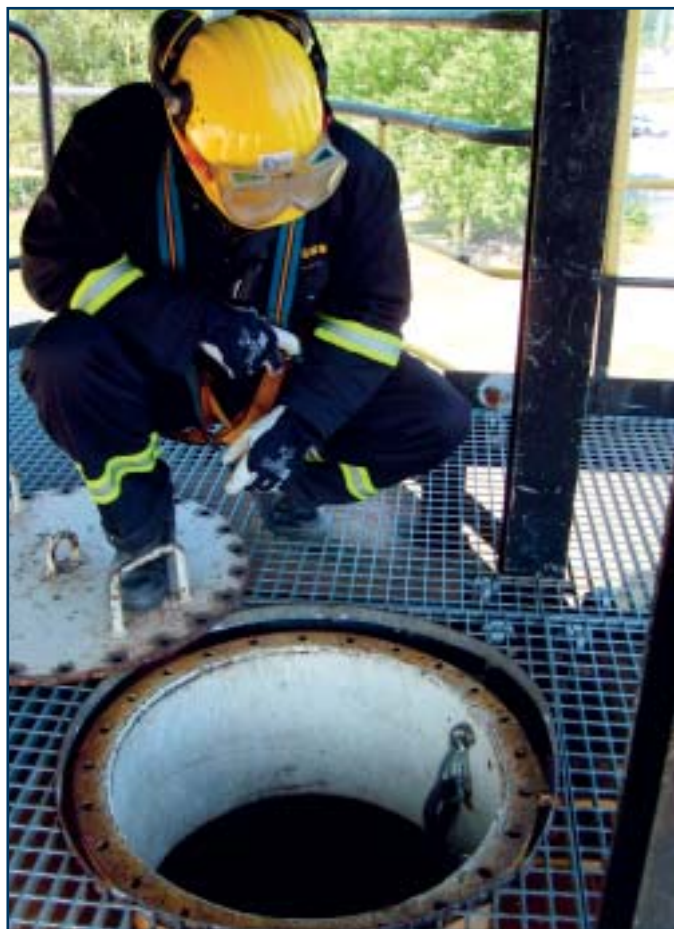
De betreders moeten steeds een veiligheidsharnas met schouderbanden dragen om een eventuele redding te vergemakkelijken.
