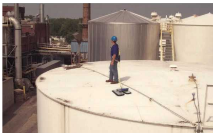
Onderhoud industriële installaties
