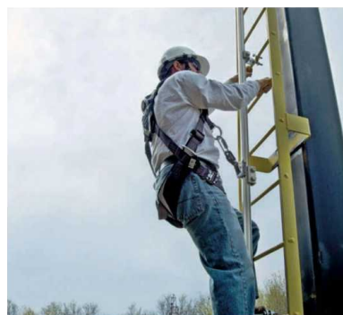
Onderhoud in masten
